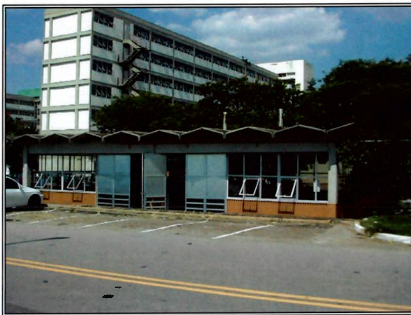
Figura 3.1: Foto ilustrativo da fachada externa da Casa das caldeiras do COSEAS
